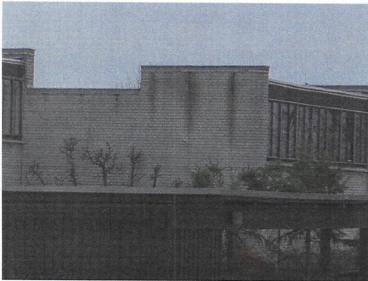
Facadeparti med sortstribning
