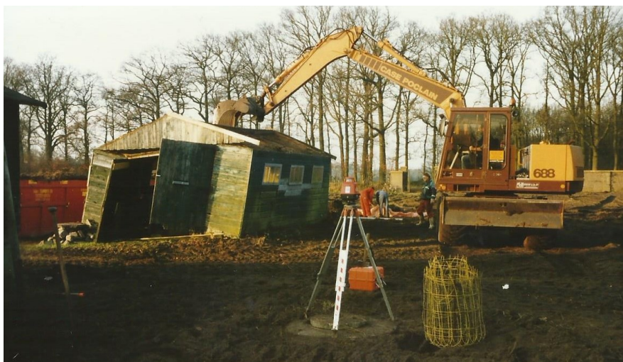
Het verwijderen van de schuur (gebouw D zie foto Bestaande situatie 1994) die voor de De Windhoos stond. Links is nog net een deel van gebouw De Windhoos zichtbaar
