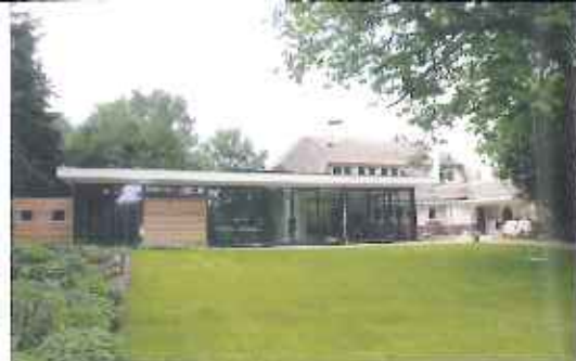
De in 2009 aangebouwde vleugel
