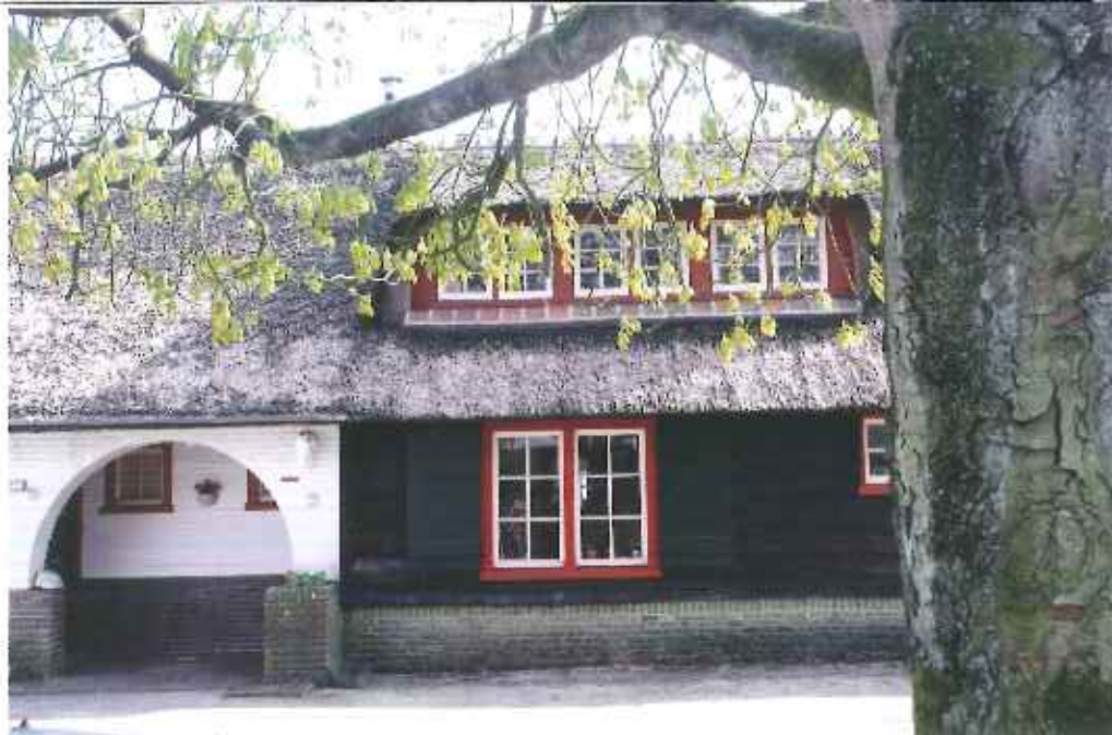
Ingang in de rechter vleugel. Binnen het portiek links de deur naar het kantoor van de modelboerderij, rechts de voordeur van de woning van de boer
