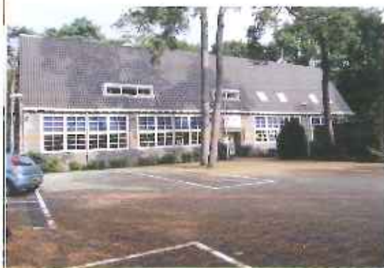
Recente foto van het gebouw van de Openbare Lagere School aan de Hertentlaan. Het gebouw dateert uit 1922. In 1959 werd het verhuurd aan de Amerikanen die op de luchtmachtbasis Soesterberg waren gestationeerd. De Openbare School had toen een nieuw gebouw gekregen aan de Hermelijnslaan.
