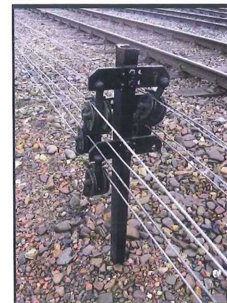
Steunpaal met trekdraden waarmee de wissels en seinen werden bediend
