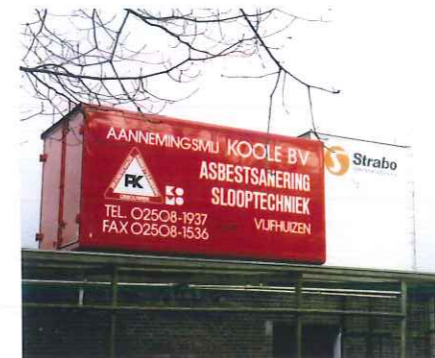
Sloop van de gebouwen van Strabo in 1994. Op de foto beneden is nog de mooie baksteenarchitectuur van de zeepfabriek "De Duif" herkenbaar
