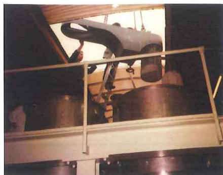
Het plaatsen van de mengmachine via het dak van de Romneyloods
