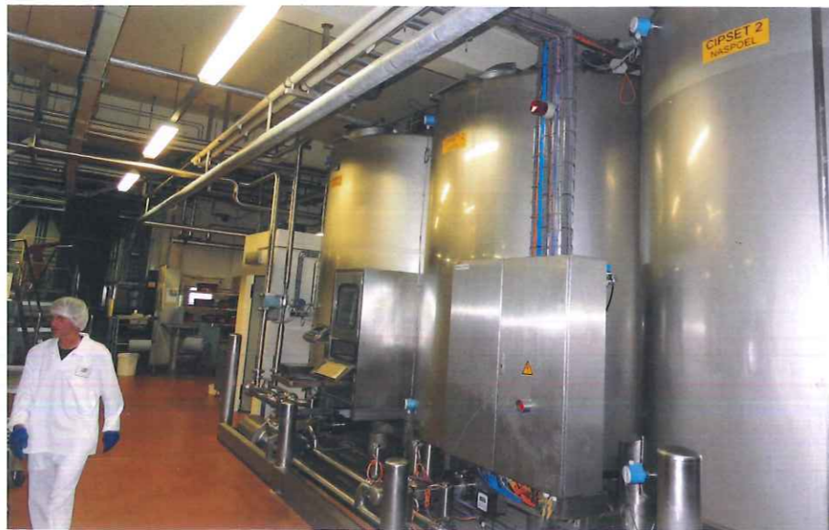
De drie verticale tanks vormen tezamen de CIP-set voor het schoonspelen van de leidingen
