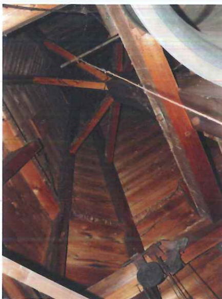
De prachtige balkenconstructie binnen in het torentje. Rechts de rand van de luidklok, rechts onder de katrollen waaraan het gewicht hangt
