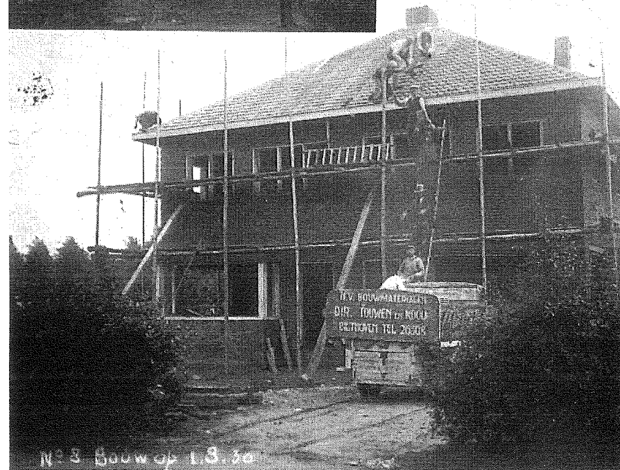
Het pand Dolderseweg 81/83 in aanbouw 23 juli 1930 resp. 1 augustus 1930
