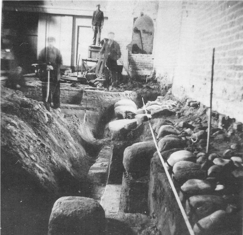
Figuur 2. Een foto langs de zuidwand van het schip (1942). De grootste keien zijn stiepen waarop houten kerken stonden. Fotograaf onbekend, collectie Rijksuniversiteit Groningen, Groninger Instituut voor Archeologie.
