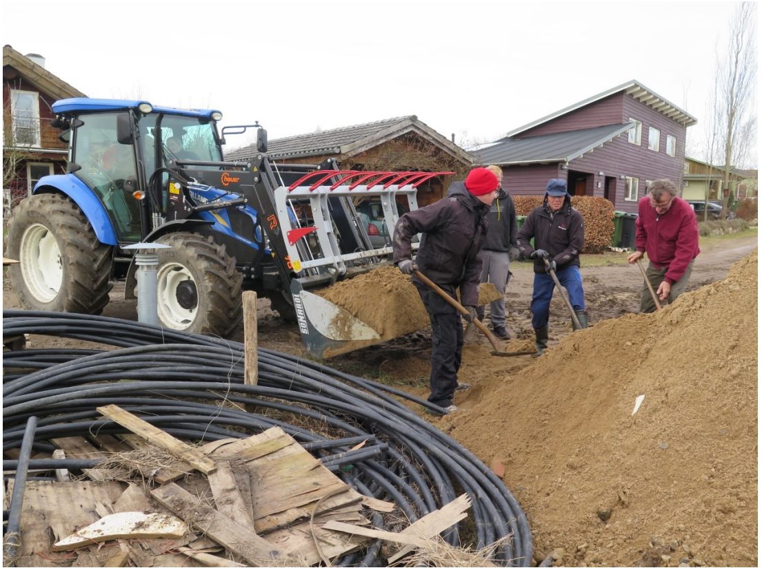
Udeholdet sørger for at redde overskydende sand fra byggeriet inden det fjernes (Foto: Ole W)
