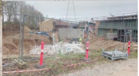
Den store BMS kran løfter bygningselmen- ter ned til kælderen i det nye byggeri (Fotos: Allan)
