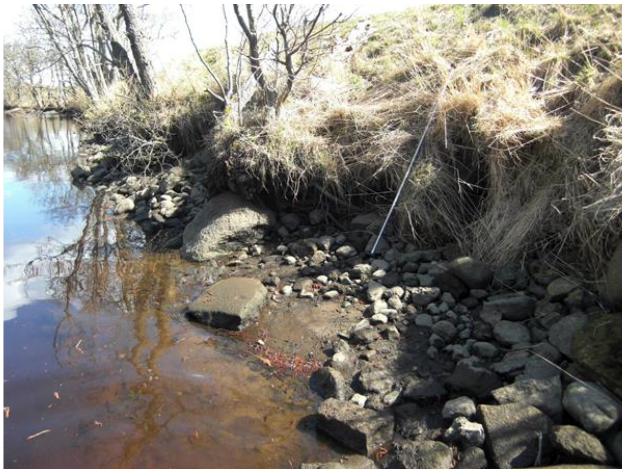
Figur 19. Erosion i Möllerännan 2010-04-16. Svallvågor från båtar i kanalen gör att sanden i de branta strandvallarna eroderar. Hastighetsgränsen i hela gamla åfåran är 5 knop. Begränsningen följs dock dåligt enligt boende i området. Foto: Olof Jönsson.
