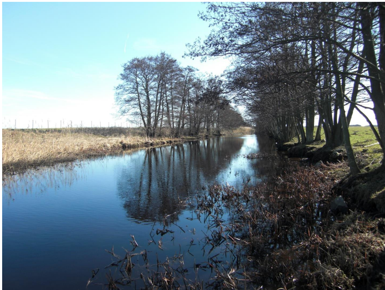
Figur 33. Strax nedströms inloppet i Graften. På norra sidan, till vänster i bild, är en lämplig plats för maskiner att komma ner till vattendraget och rensa. Härnestsgraftern 2010-04-15. Foto: Olof Jönsson
