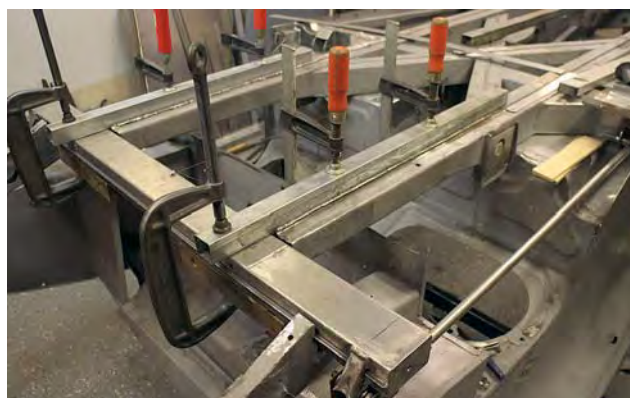
Nedan: Bakre tvärbalk fixerad inför svetsning.
