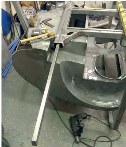
Förstärkningsrör slås in
