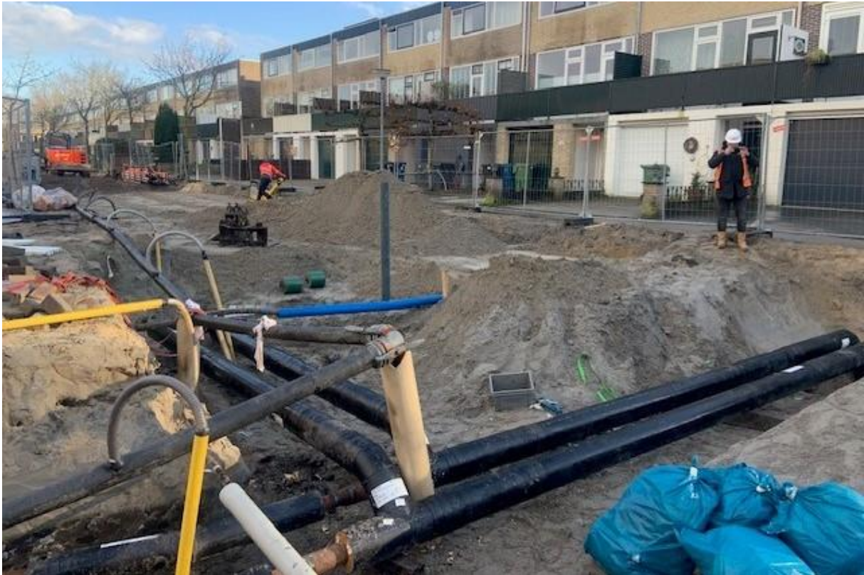
Aanleg warmtenet in Alkmaar HVC
