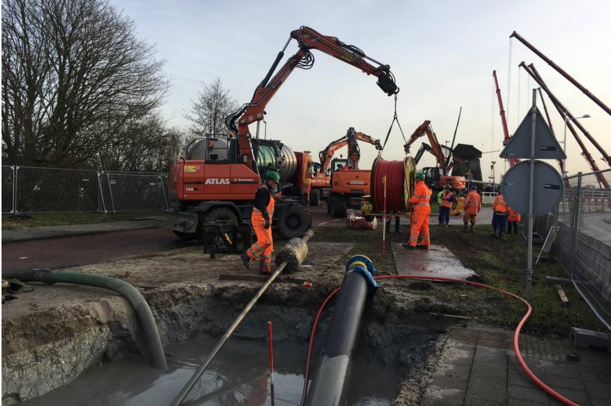
Aanleg warmtenet in Alkmaar
