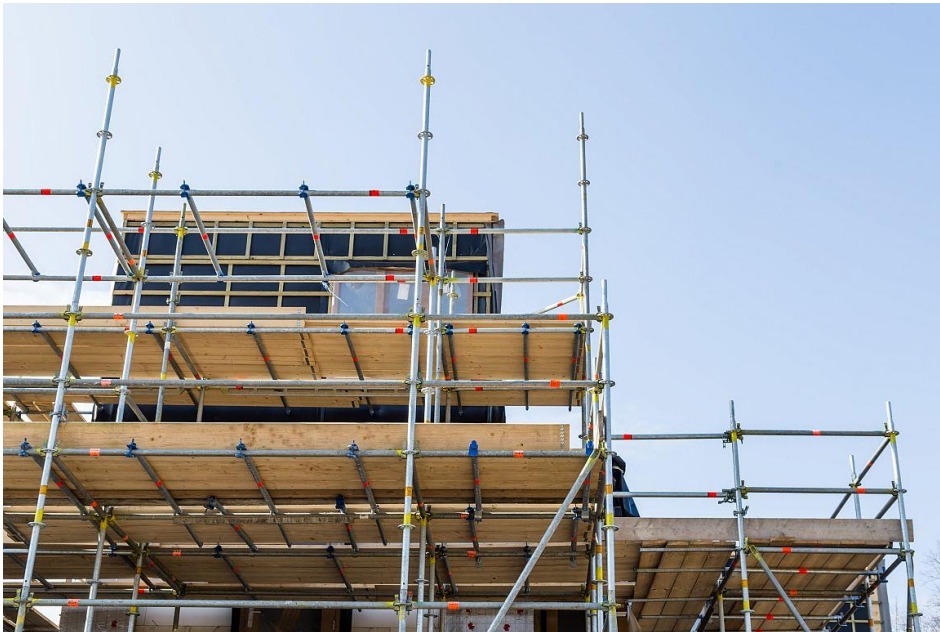
Woningen in aanbouw
