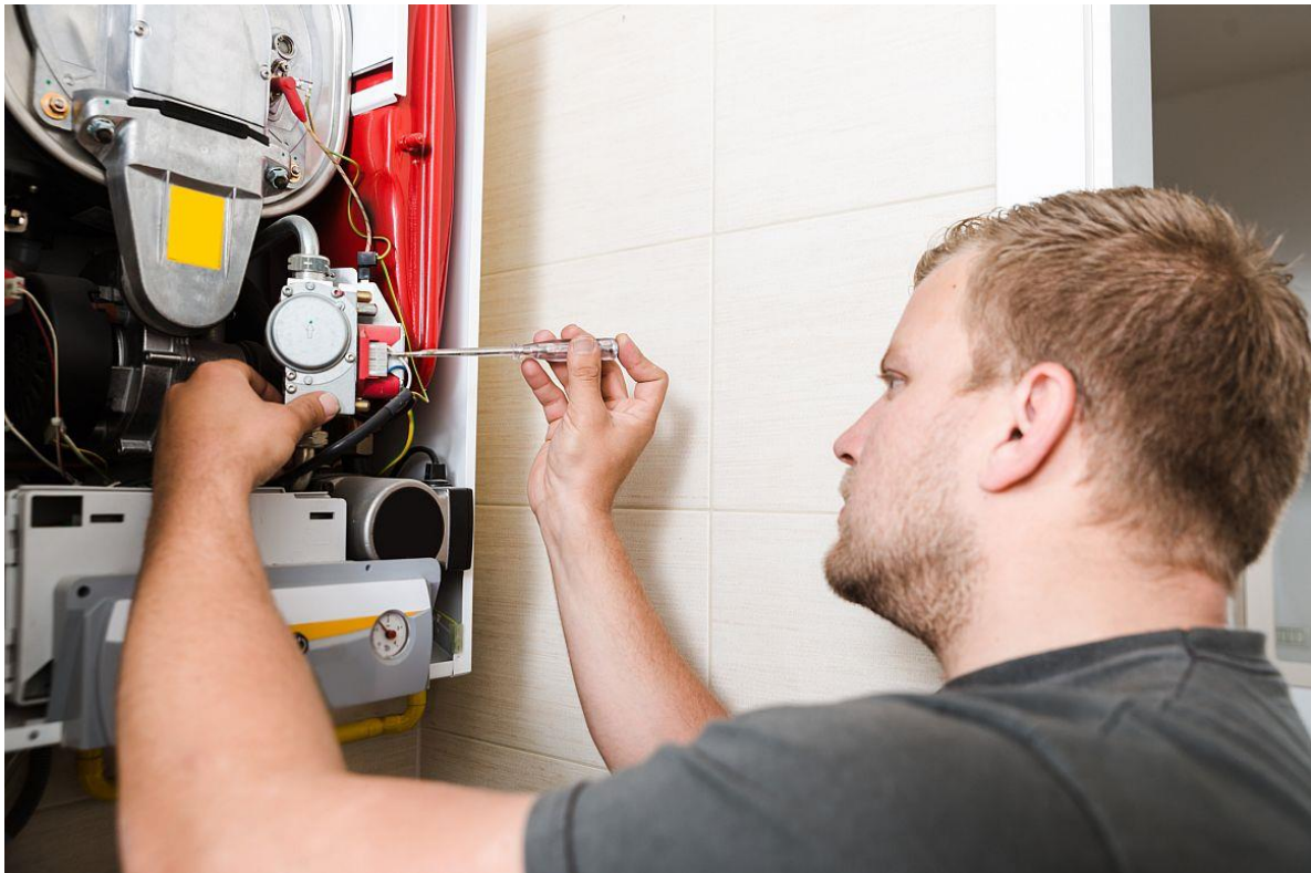
Reparatiewerkzaamheden aan een cv-installatie
