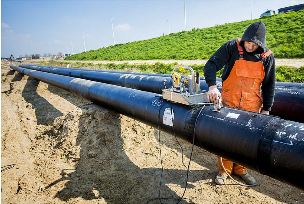
Aanleg warmtenet Nijmegen
