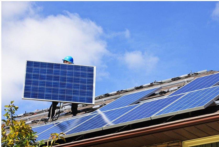
Installatie van zonnepanelen op het dak van een huis.
