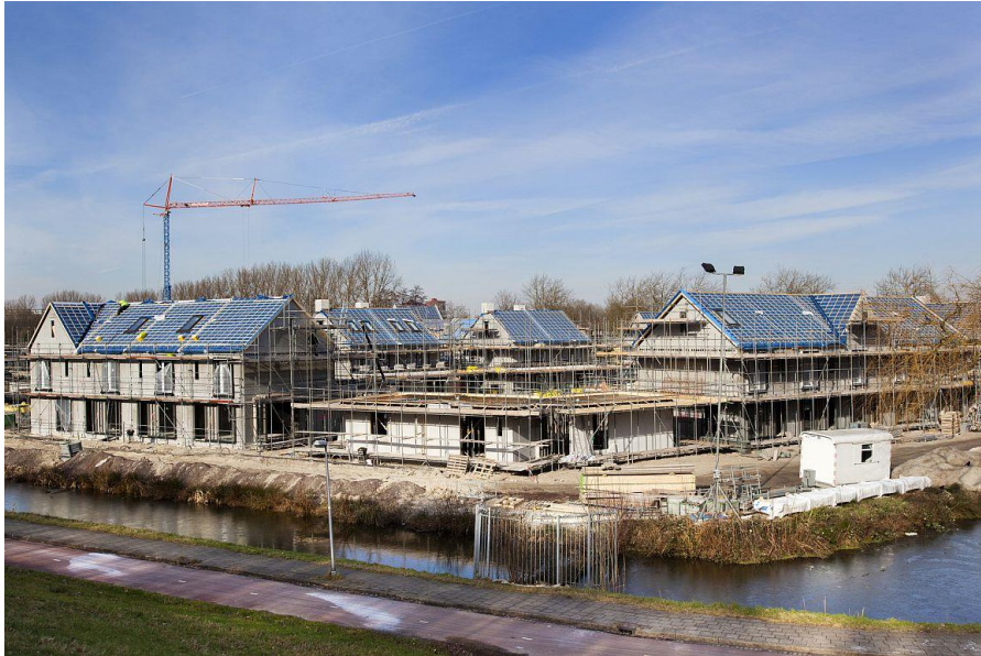
Woningen in aanbouw
