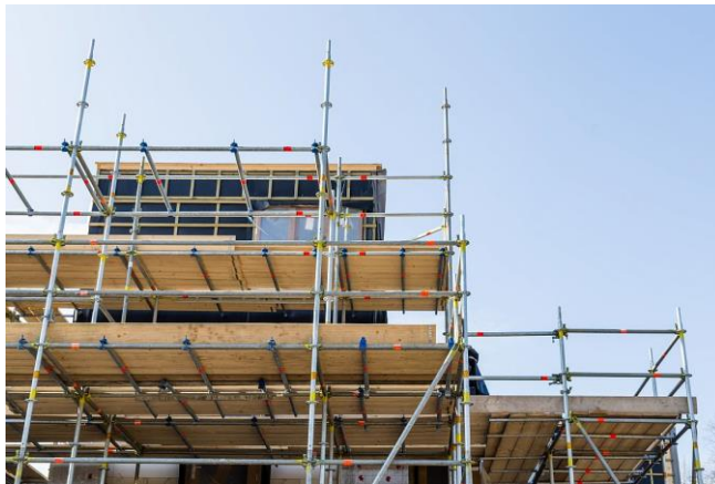
Woningen in aanbouw
