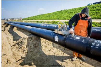
Aanleg warmtenet Nijmegen
