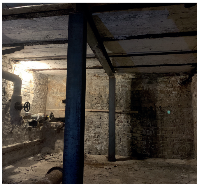
Dæk over portgennemgang sikres ift. korrosion
