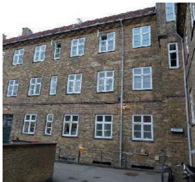
Oprikelige vinduer istandsættes og energiforbedres
