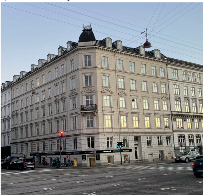
Ejendommen set fra gaden
