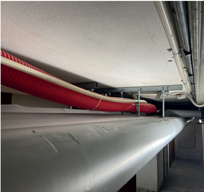
Der efterisoleres mod kælder
