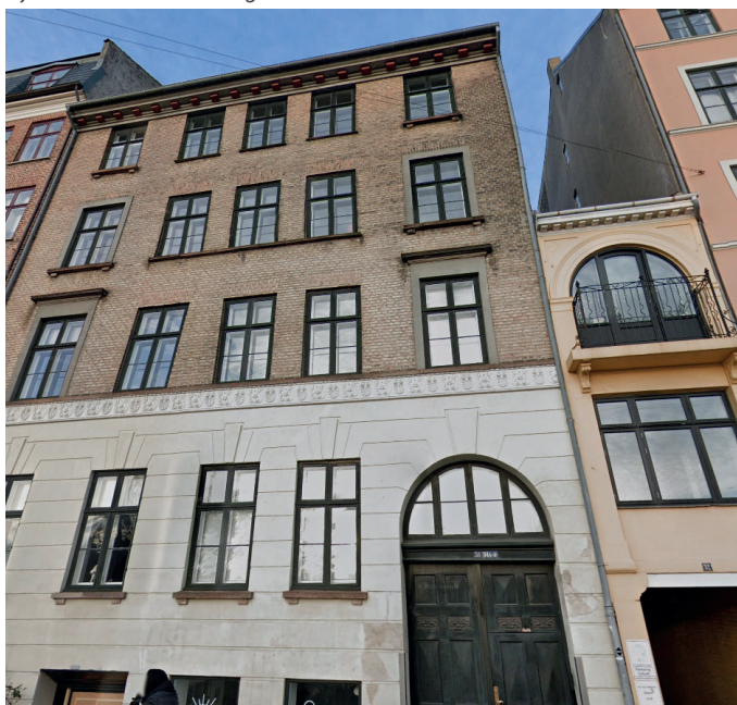
Ejendommen set fra gaden
