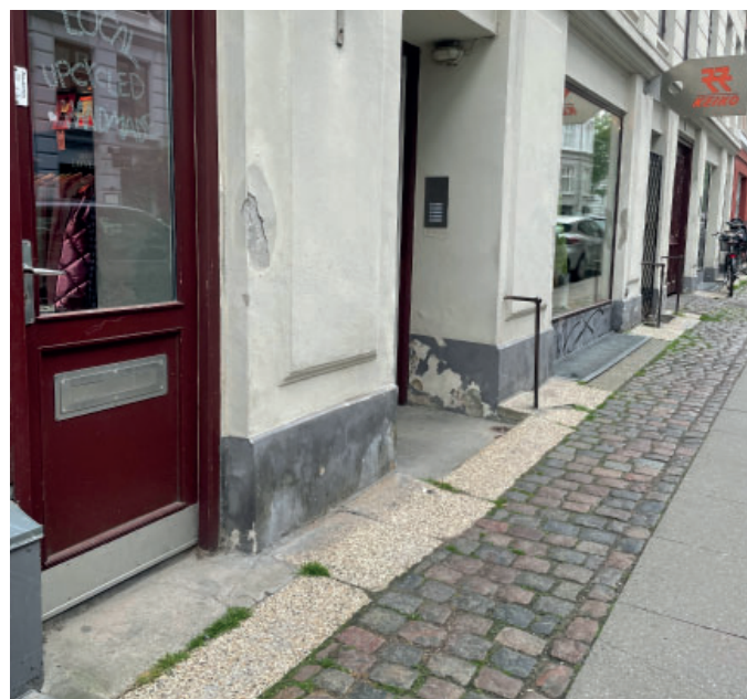
Ejendommen fugtsikres bl.a. ved etablering af omfangsdræn
