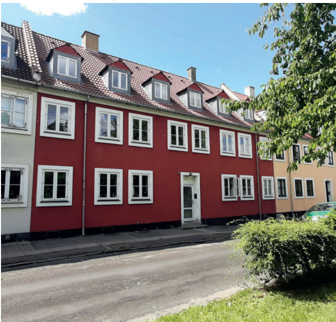
Ejendommen set fra gaden
