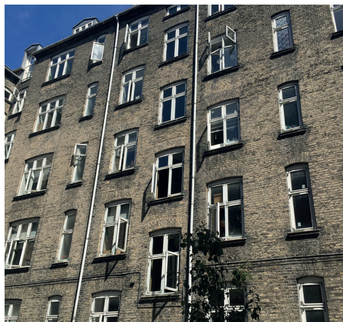
Isolering af gårdface og udskiftning af alle vinduer til trævinduer
