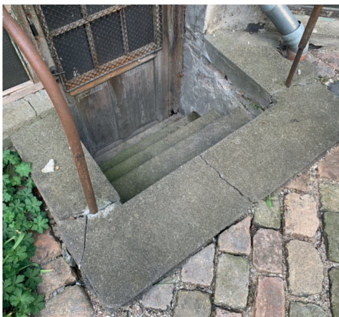
Kældertrapper og lyskasser skybrudssikres
