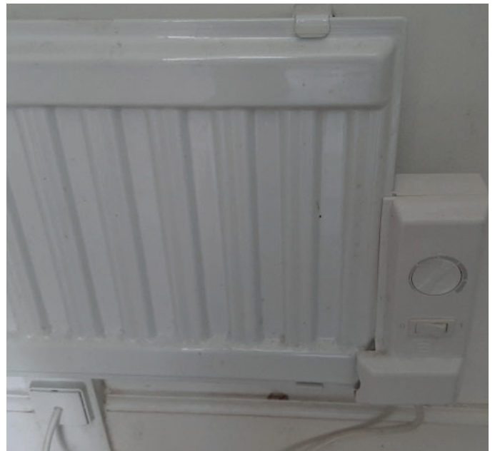
Etablering af nye radiatorer i lejligheder
