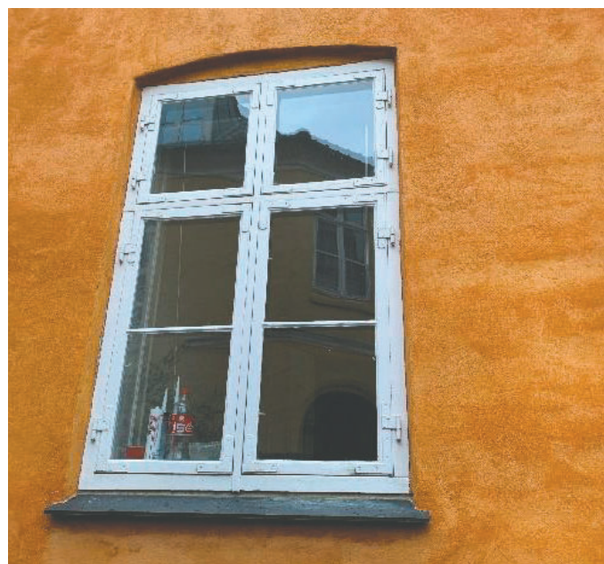
Der etableres forsatsrunder på oprindelige vinduer
