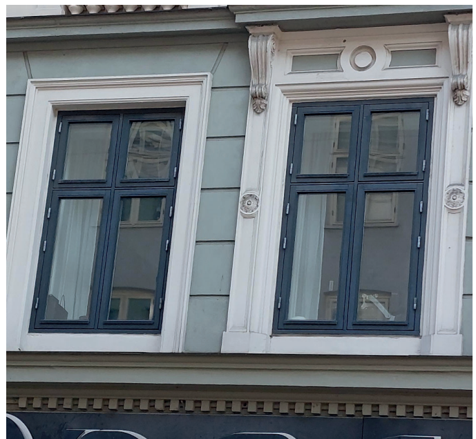
Eksisterende facadedeltajer ved vinduer
