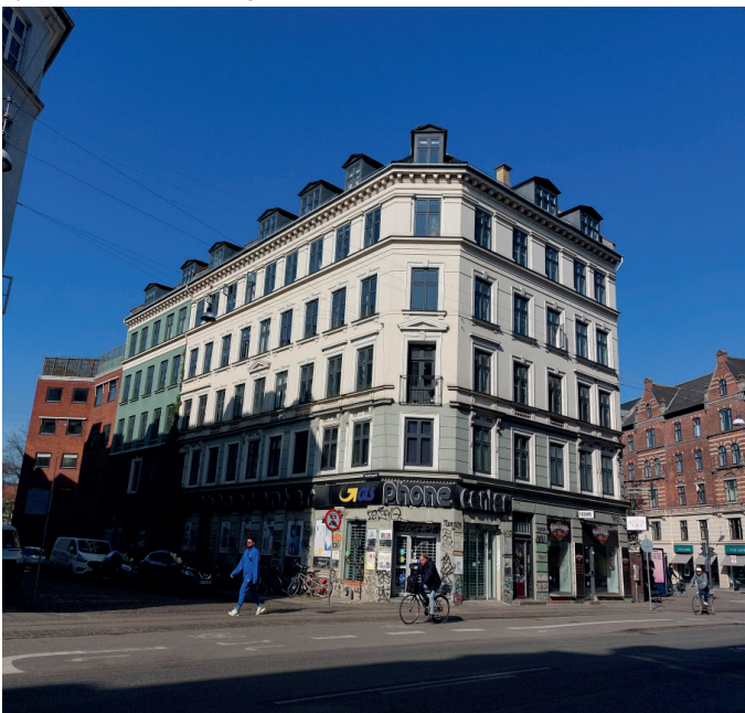
Ejendommen set fra gaden
