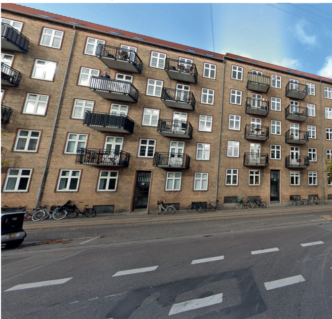
Ejendommen set fra gaden
