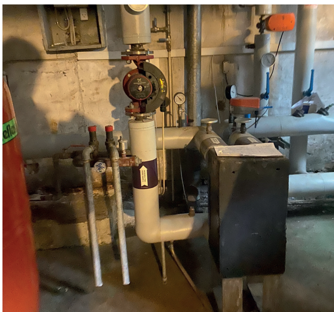
Varmeanlæg og vandinstallationer energiforbedres
