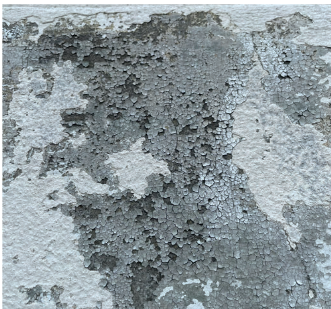
Forbedret ventilation af kældere
