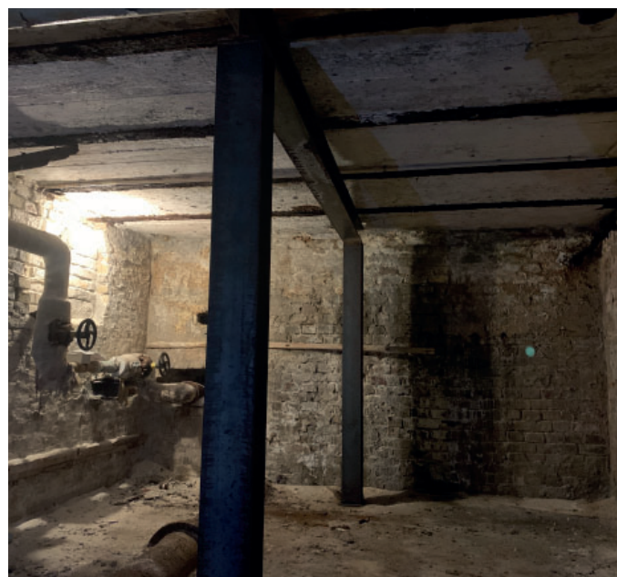
Dæk over portgennemgang sikres ift. korrosion
