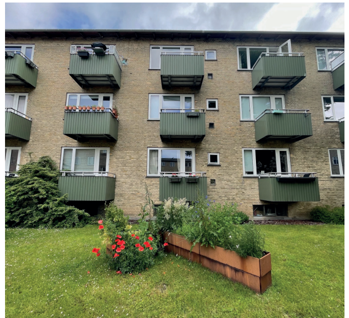
Ikke oprindelige vinduer udskiftes til trævinduer
