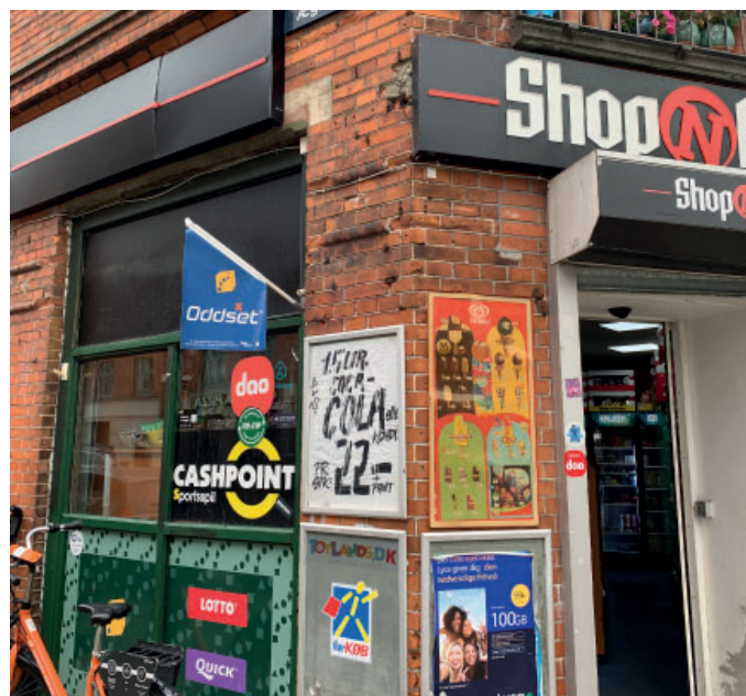
Udbedring af murværk og underfacade
