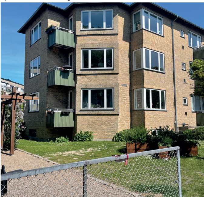
Ejendommen set fra gaden
