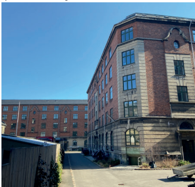
Ejendommen set fra gaden
