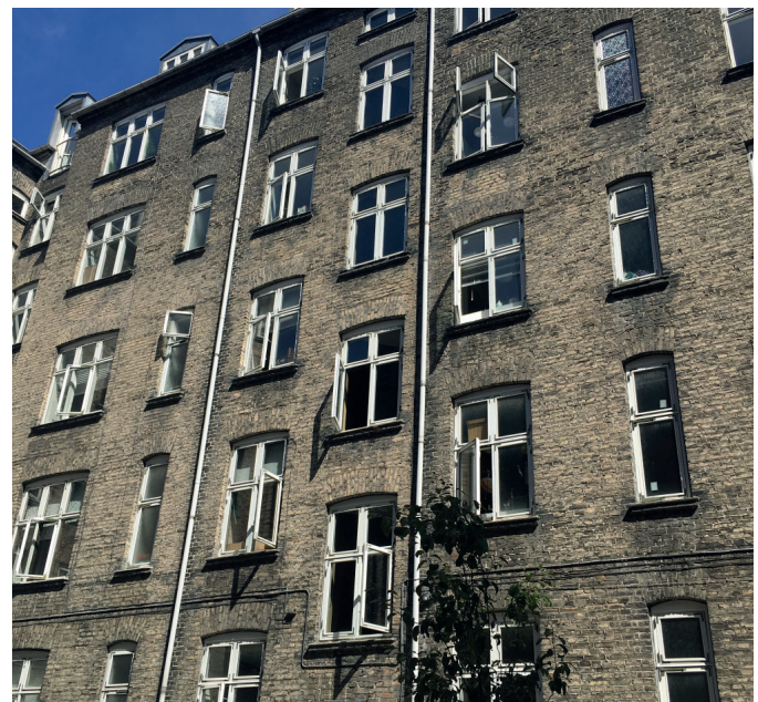
Isolering af gårdface og udskiftning af alle vinduer til trævinduer
