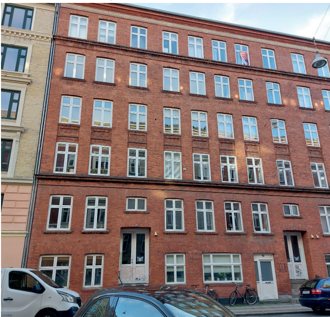
Ejendommen set fra gaden
