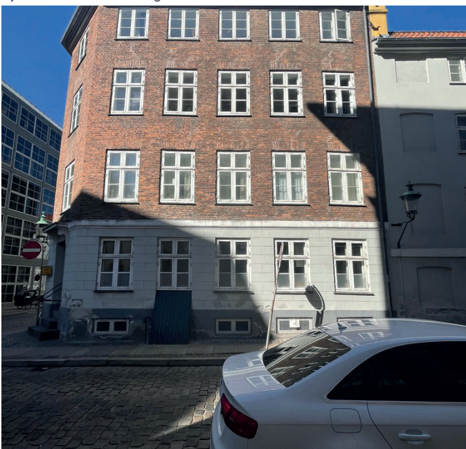
Ejendommen set fra gaden
