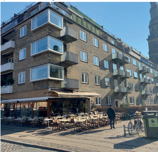
Ejendommen set fra gaden
