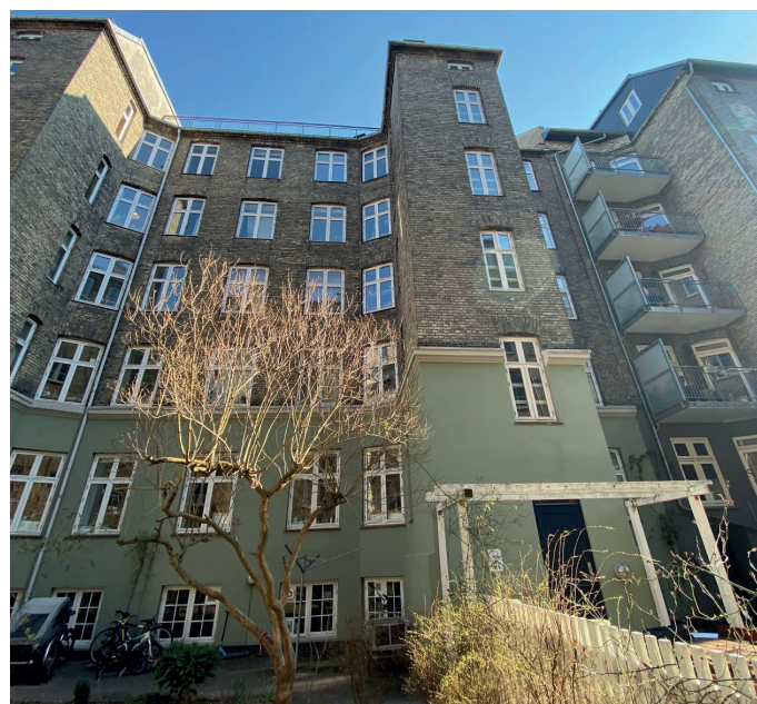
Trappetårne isoleres udvendigt
