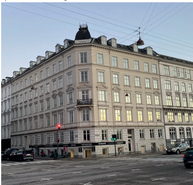
Ejendommen set fra gaden
