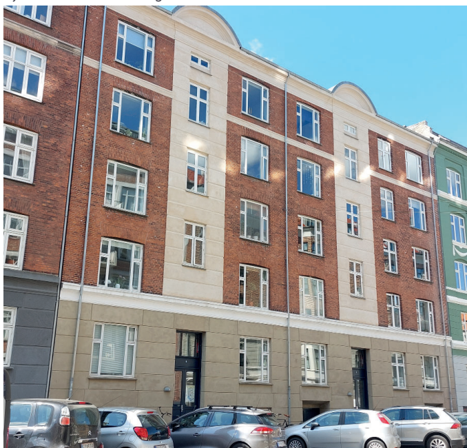
Ejendommen set fra gaden
