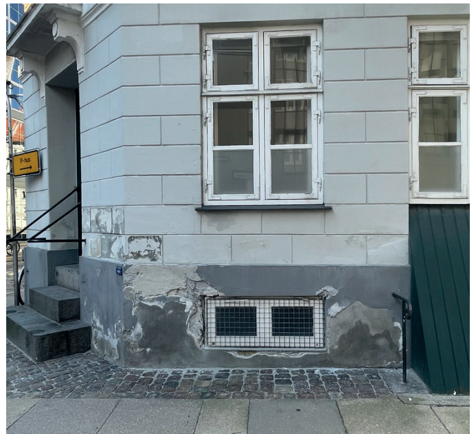
Fugtsikring af fundamenter og kælder
