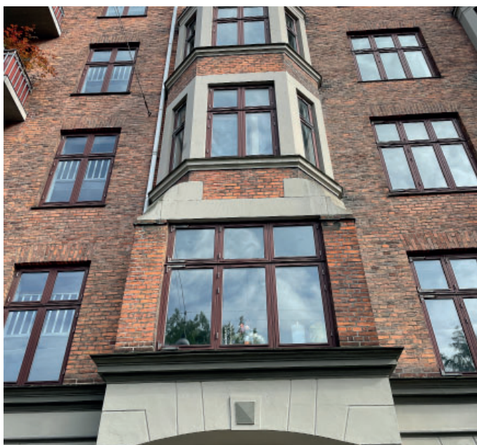
Vinduer udskiftes til koblede- og støjdæpende trævinduer
