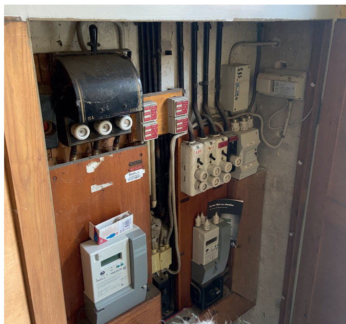
El-tavler udskiftes i alle lejligheder
