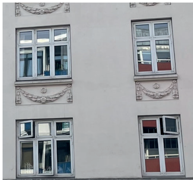
Udskiftning af vinduer til koblede trævinduer
