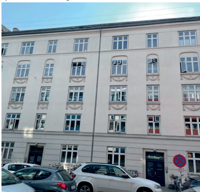
Ejendommen set fra gaden
