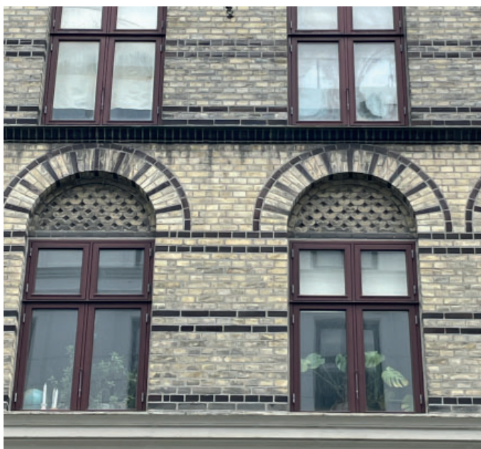
Vinduer udskiftes til koblede trævinduer
