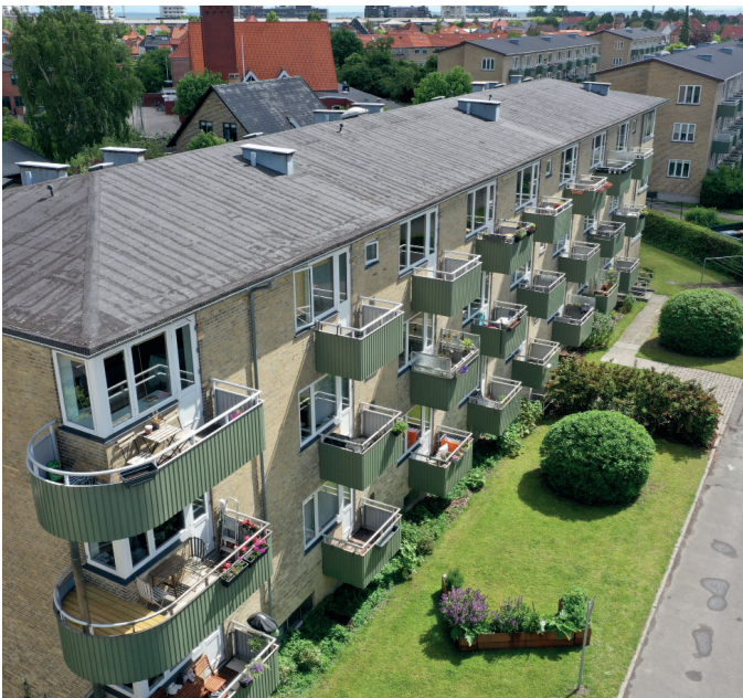
Tag udskiftes og efterisoleres
