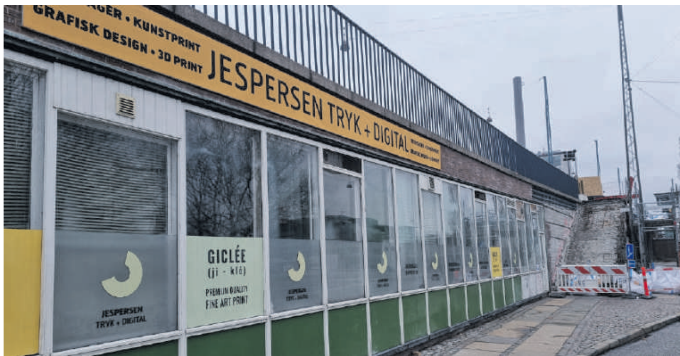
Renoveringen af Langebro går hårdt ud over det lokale erhvervsliv. Værst over trykkeriet Jespersen Tryk + Digital, der helt må fraflytte. Foto: Jesper Schou Hansen / Havnefronten.
