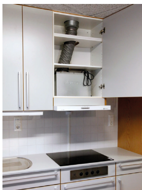
Kanal direkt påkopplad på frånluftsdonet.
