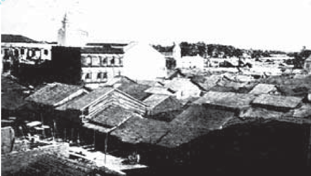
ရန်ကုန်မြို့၊ ပန်းဆိုးတန်းနှင့် ဘားလမ်းကြားရှိ ၃၄၊၃၅နှင့် ၃၆ လမ်းတို့တွင် စည်းကမ်းမဲ့စွာ ဆောက်လုပ်ထားသော တဲအိမ်များကို မီးမလောင်မီ ဤသို့ တွေ့မြင်ရသည်။
