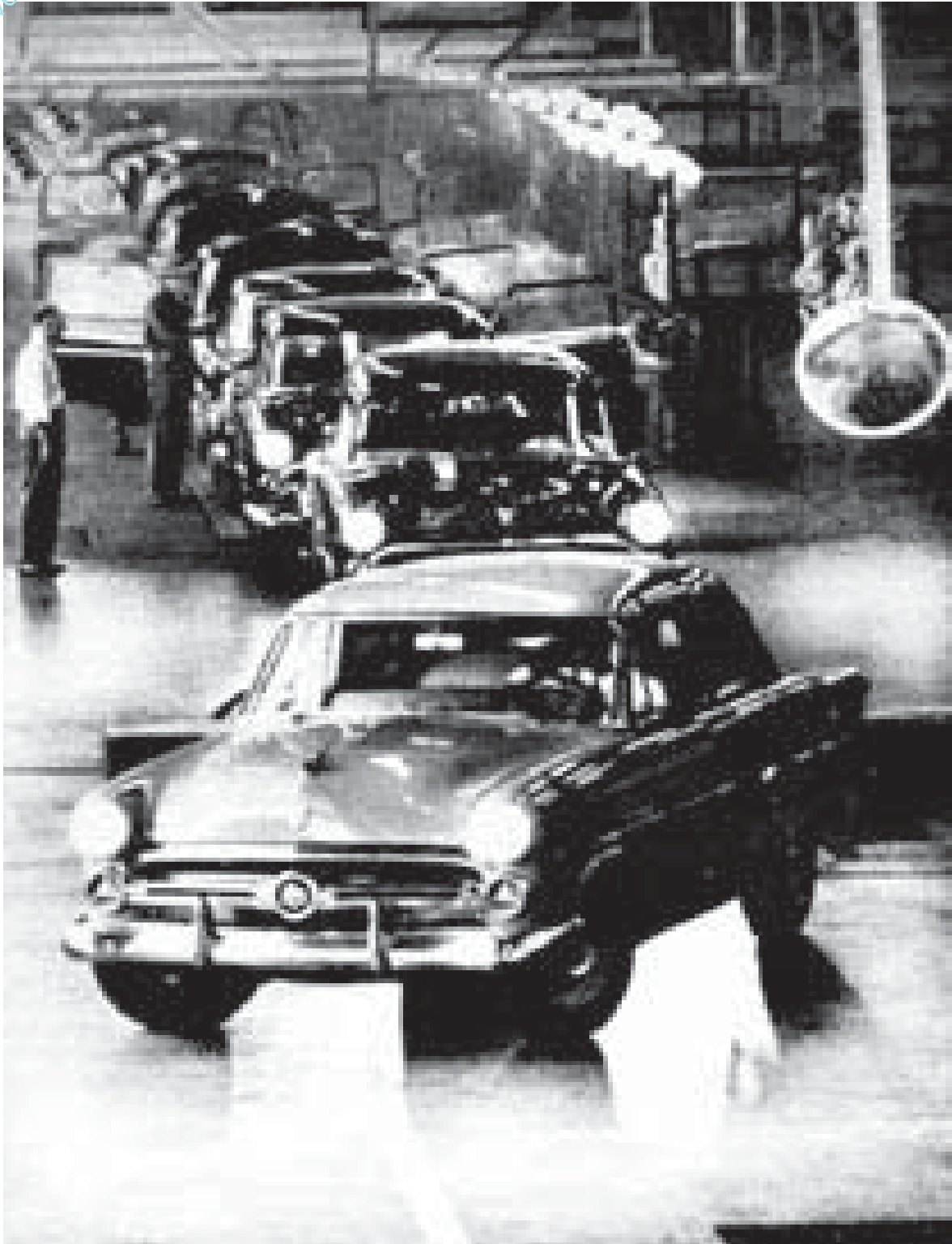
မော်တော်ယာဉ် ထုတ်လုပ်သော စက်ရုံကြီးအတွင်း တွေ့မြင်ရသောရှုခင်းတစ်ခုဖြစ်သည်။ စီတန်းတပ်ဆင်ယူနည်းဖြင့် မော်တော်ယာဉ် အစိတ်အပိုင်းများကို ဆင့်ကဲတပ်ဆင်ပြီးနောက် စမ်းသပ်ရန် မောင်းနှင်ကြည့်ရသည်။
