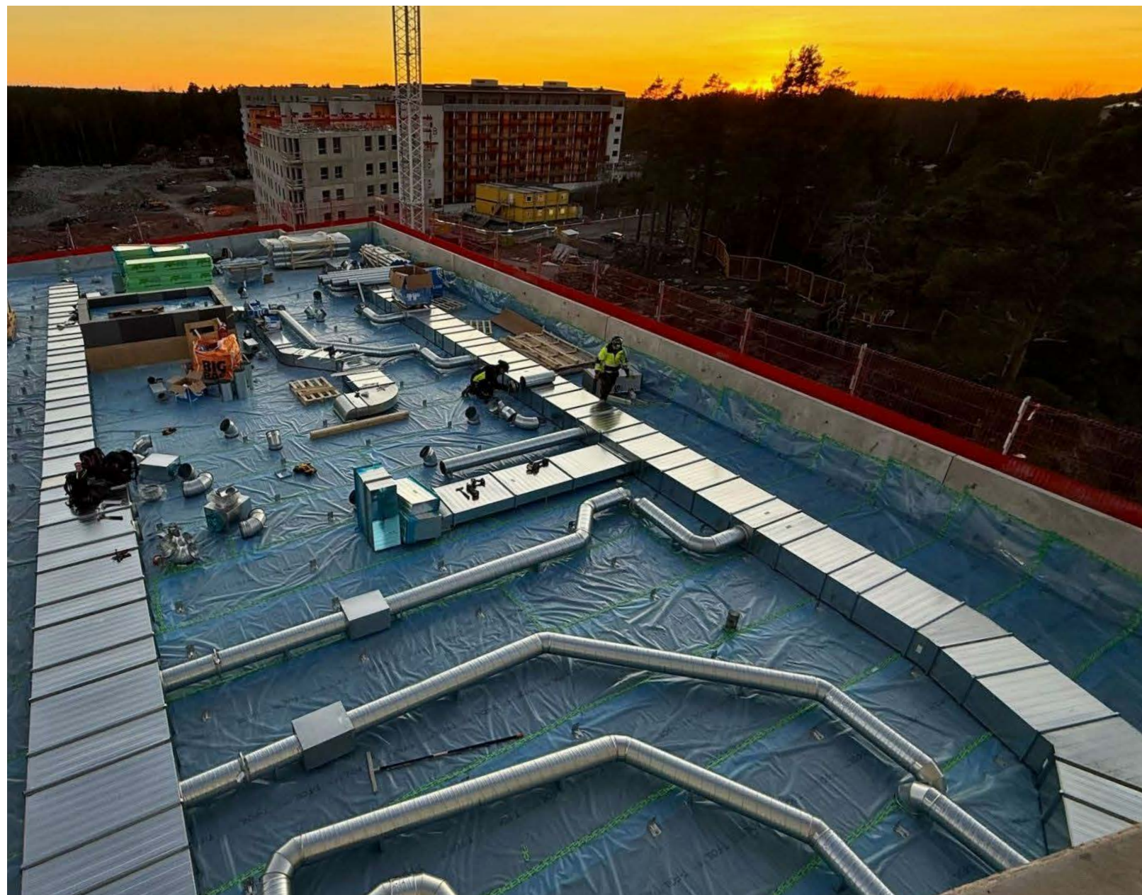
Ventilationsarbeten utförs av LP Vent på projektet Campus Flemingsberg i Huddinge
