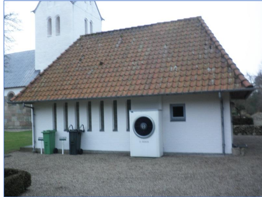
En landsbykirke med elvarme og varmepumpe. Her er udedelen placeret ved graverhuset.
