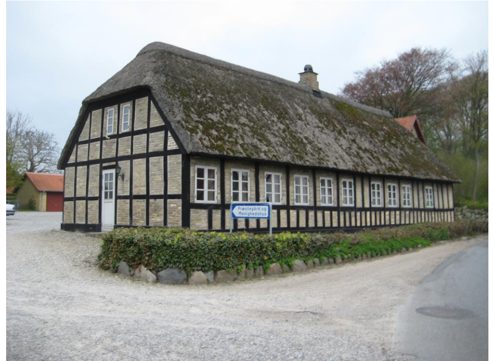
Ældre sognegård med luft-luft varmepumpe
