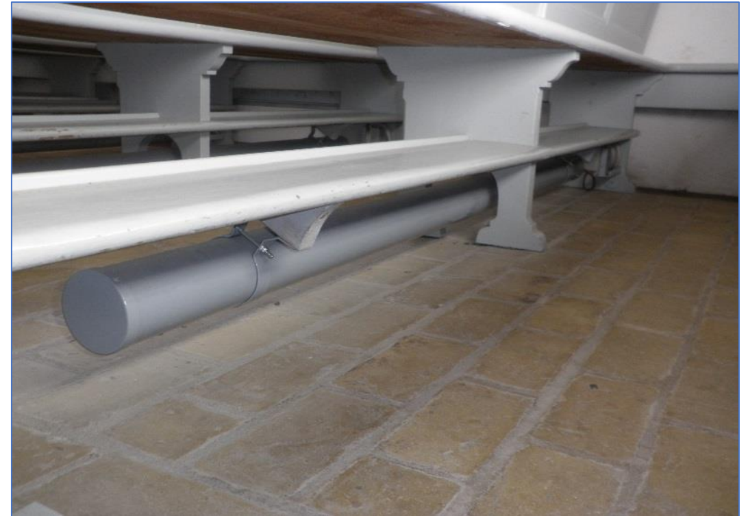
God varmfordeling med elvarme under bænkerne
