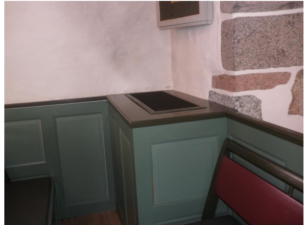
"Kasse" til indblæsning af luftvarme i kirken
