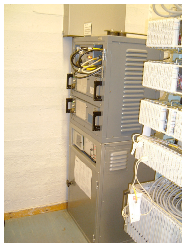
Radiotelerum med mottagare, RK02 ,FMR7 och FMR18
