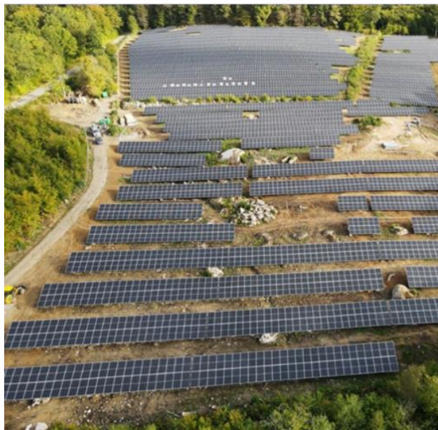
Figur 12. Bilden visar en anläggning under uppförande i skogsmark.
