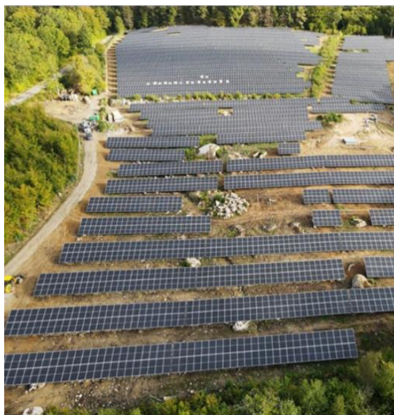
Figur 15. Bilden visar en anläggning under uppförande i skogsmark.
