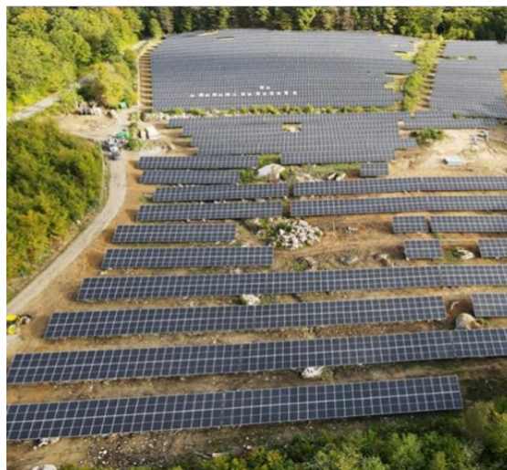
Figur 12. Bilden visar en anläggning under uppförande i skogsmark.
