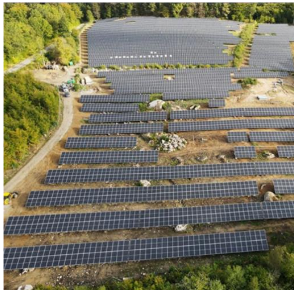
Figur 13. Bilden visar en anläggning under uppförande i skogsmark.
