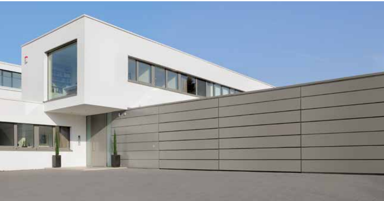
Plankekledning på monteringsstedet med laminerte aluminiumsplater
