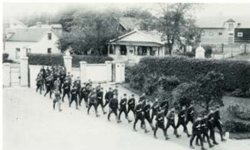
Infarten till T2 vid kanslihuset. Byggnaden längst upp till höger var en av kårens bilverkstäder under beredskapsåren och kallades "Över verkstaden". Samtliga dessa byggnader är nu rivna.
