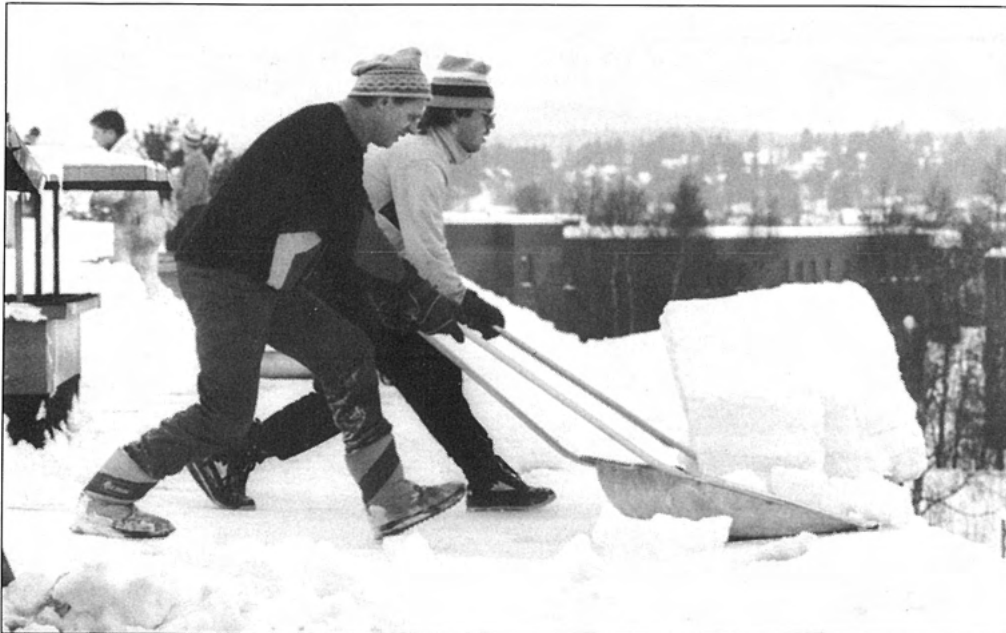
Lokaler fick utrymmas när taket i F-hallen rasade in p g a för stort snötryck. Alla tak skottades för att förhindra flera takras.
