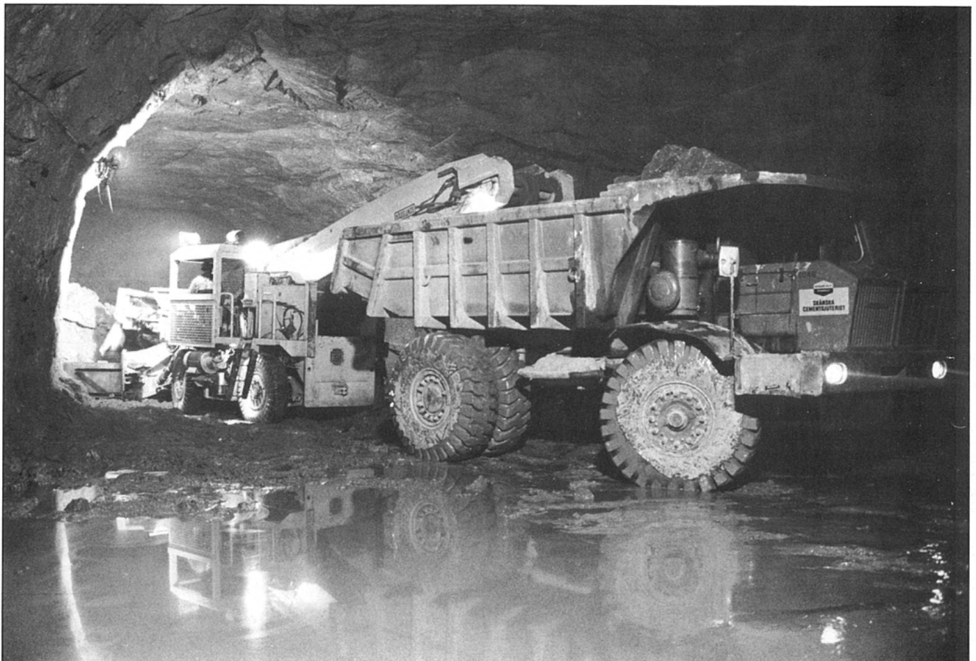
Hägglunds Häggloader gjorde ett mycket bra arbete vid kraftverksbygget i Björna.
