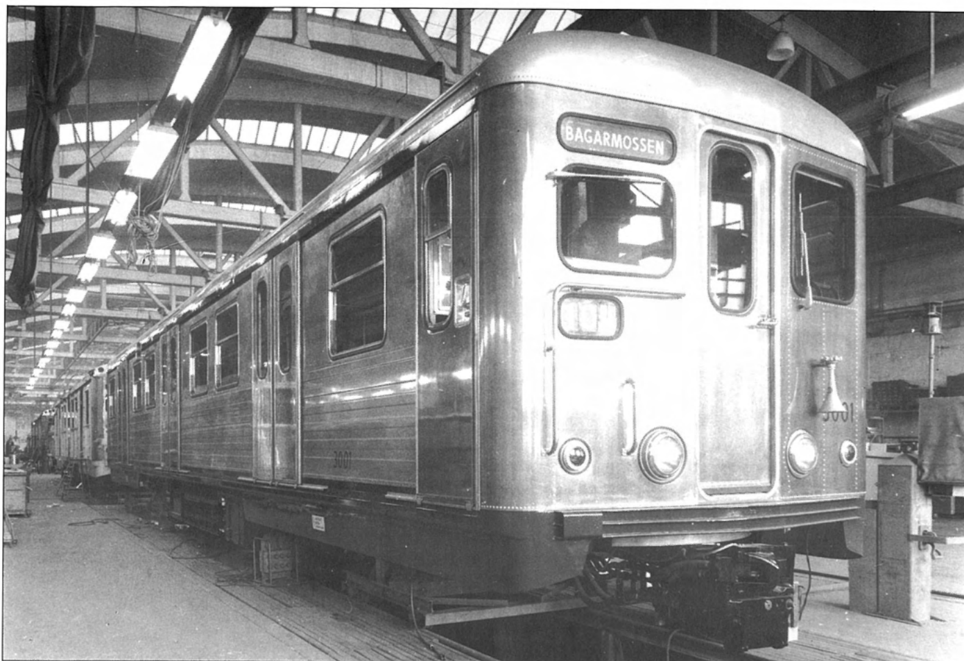
Silvertåget var en provserie tunnelbanevagnar i aluminium. Allt utom kontrollern var tillverkat på Hägglunds.
