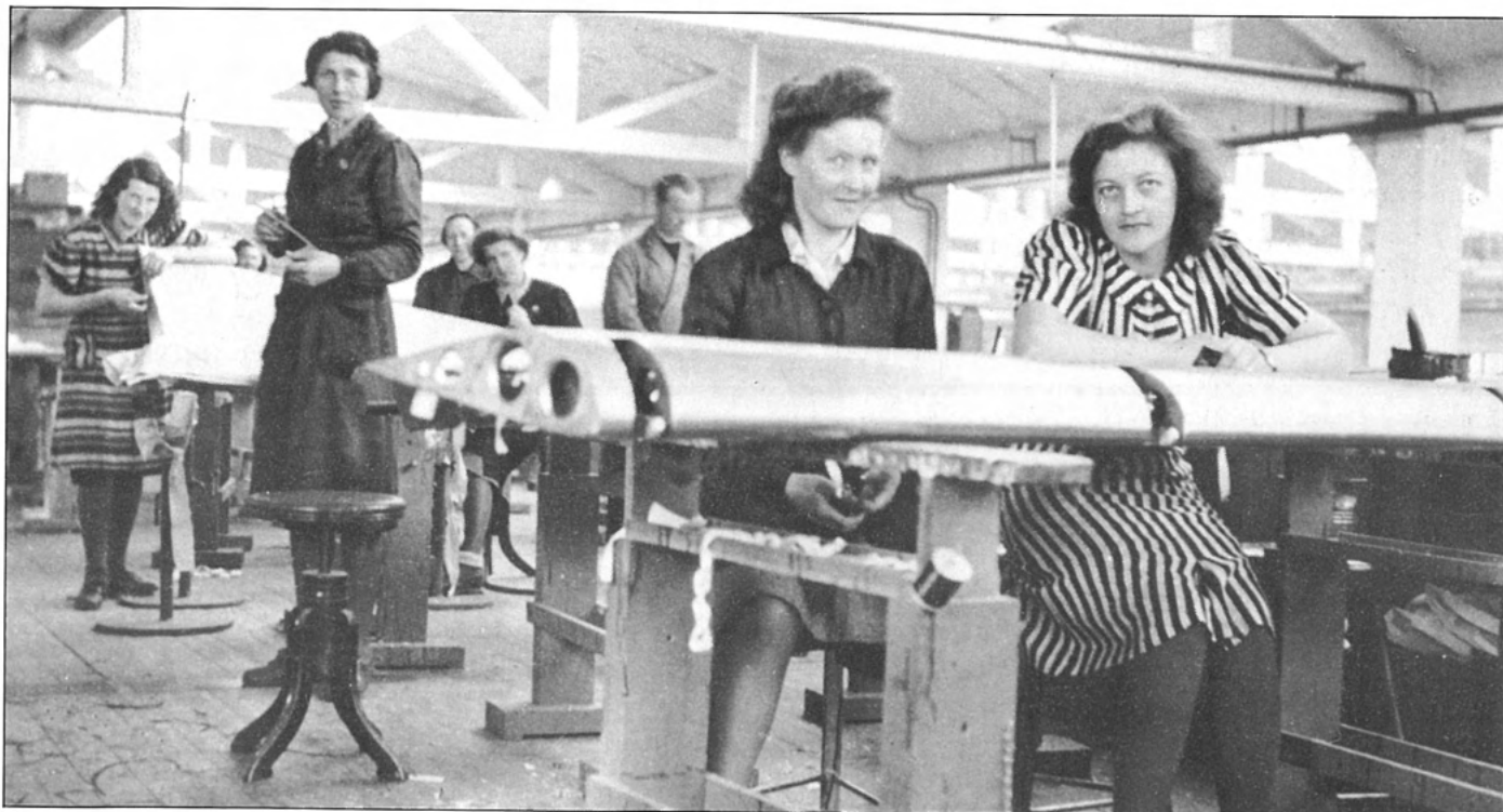
Tillverkning av höjdroder till J22:an, damen stående på bilden är Linnea Jonsson.
