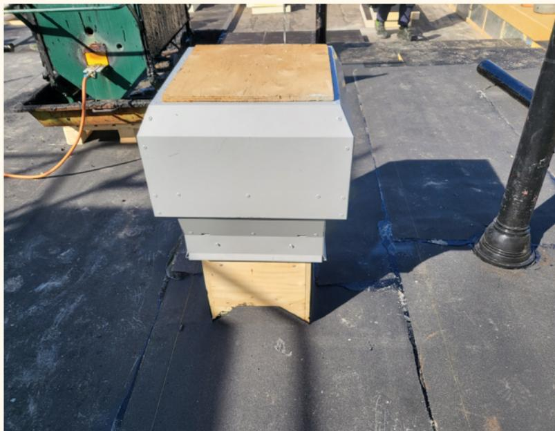
*Пример детали с высоким риском. Показан пример проходки с зазором, требующей особой осторожности. Отрицательное давление в зазоре может привести к тому, что горячий воздух будет засасываться на чердак.*
