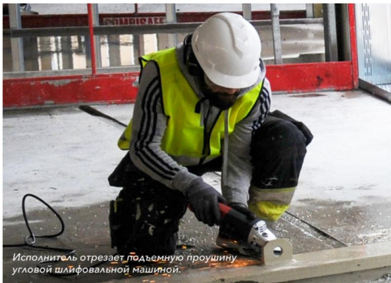
*Исполнитель отрезает подъемную проушину угловой шлифовальной машиной.*
