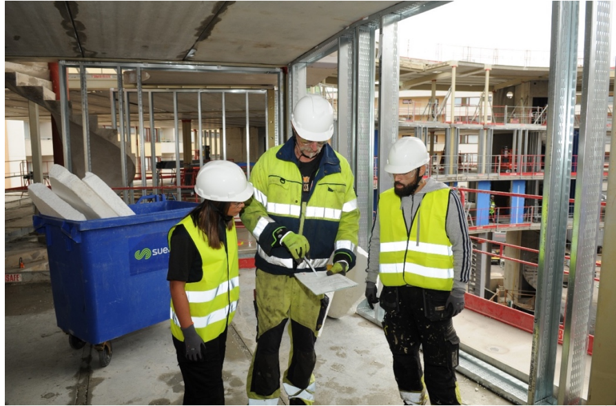
منفذ، مسؤول تراخيص ومراقب حريق يحضرون لعمل ساخن قابل للاشتعال.
