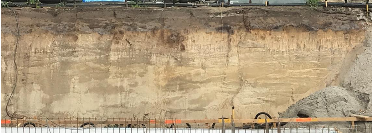
Afbeelding 9: De noordwestwand van de bouwput in later stadium met beter uitgeprepareerde geul vormen. Het rechter deel van deze foto correspondeert met de foto rechtsonder op afbeelding 6.
