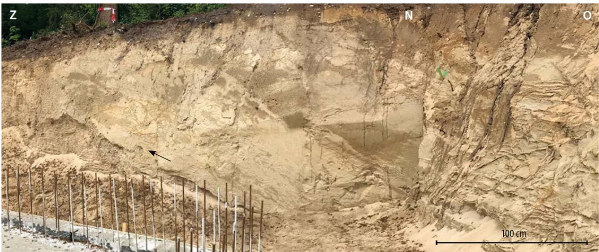
Afbeelding 55: Bouwput D, zuid-noord en west-oost richting, met horizontaal tot schief gelaagde zanden boven het overschuivingsvlak. Overschuiving aangegeven met pijl.
