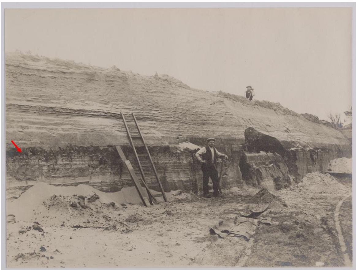
Afbeelding 13: Horizontaal gelaagde dekzanden op de Soesterweg in Amersfoort met (gecryoturbeerde?) bodem bij pijl (Archief Eemland, rond 1920).
