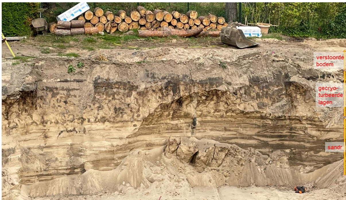
Afbeelding 90: Bouwput aan de Baarnseweg in Bosch en Duin; subhorizontaal tot lokaal scheve gelaagde zanden doorsneden door geultjes typerend voor sandr afzettingen overdekt door een gecryoturbeerd laagpakket.
