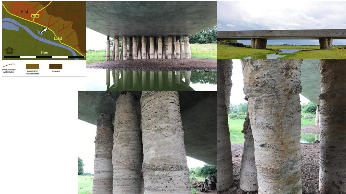
Afbeelding 95: Locatieschets en foto collage van pilaren bedekt met grofkorrelige grindrijke horizontaal tot scheefgelaagde zanden, vorstwig aanwezig op rechter foto (foto's auteur uit 2020).
