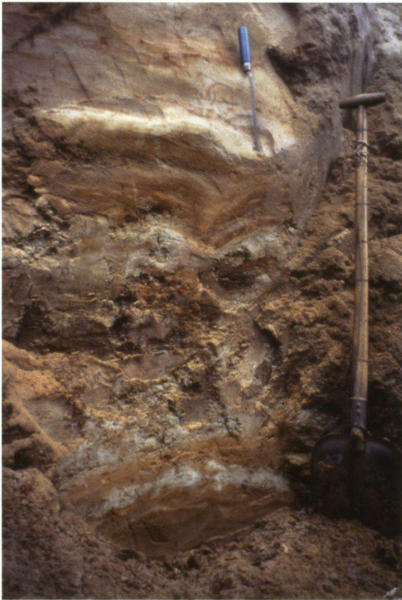
Afbeelding 6. Kame-afzetting met leem- en kleilagen in een 2 m diepe bouwput aan de Laanstraat in Hilversum, gelegen op circa 300 m van de stuwwalgrens. De lengte van de voegspijker is 31 cm. Zie afbeelding 1, pt. 7.
