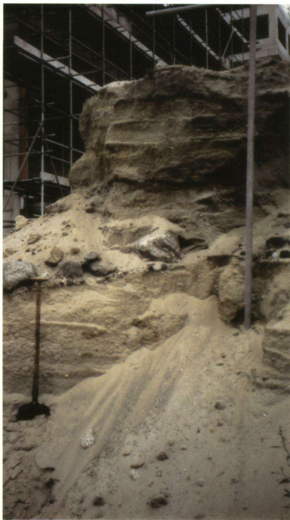
Afbeelding 18. Bekkenafzetting opgebouwd uit een afwisseling van klei- en zandlaagjes. Bouwput uitbreiding Wereldomroep. Zie afbeelding 1, pt. 10.
