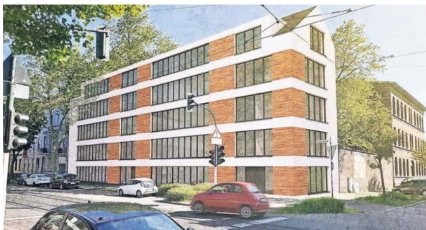
Die geplante Unterkunft an der Feldstraße/Kölner Straße. Im Hintergrund die ehemalige Schule.
