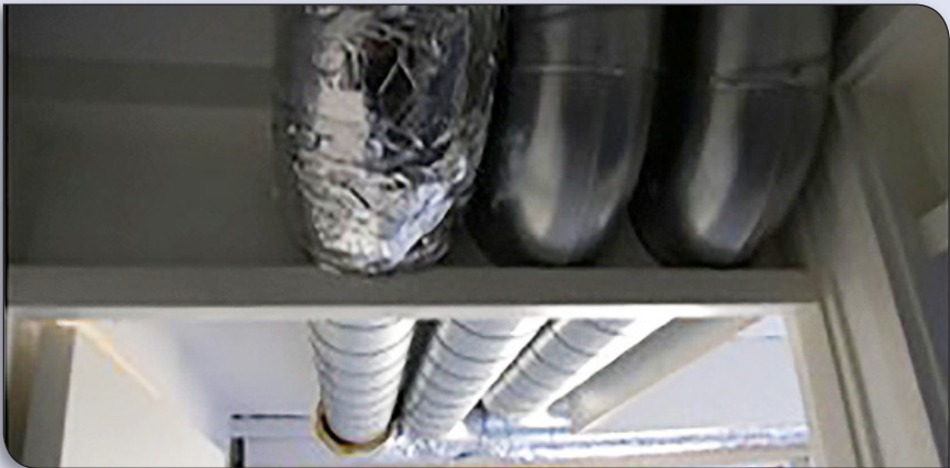
Ventilationsrør fra de første prøvehuse
