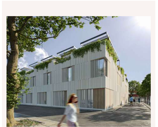
Vista de fachada.
