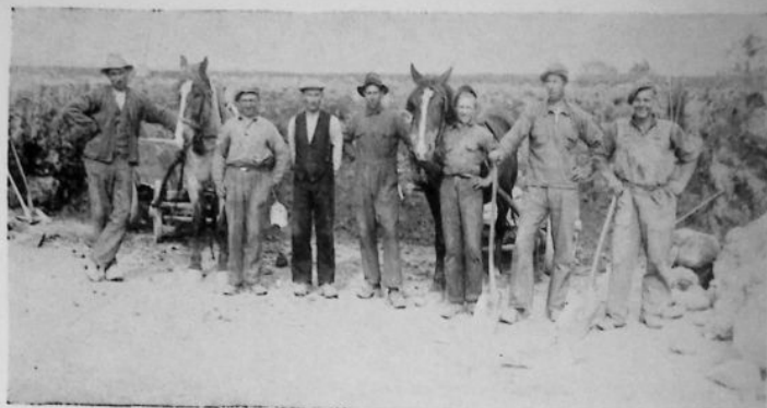
Arbetslag vid vägbygget Frenninge-Vallarum-Molleröd 1932—1935.
