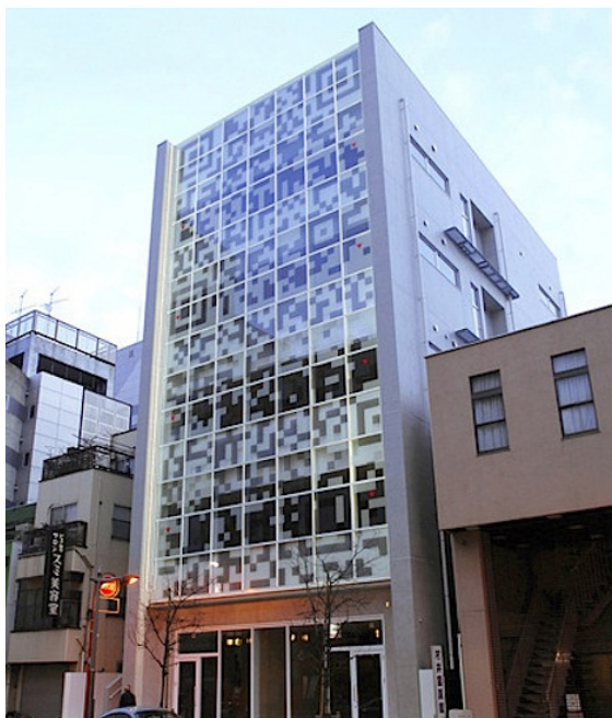
N Building costruito in Giappone è una struttura commerciale dove i cartelloni pubblicitari sono stati sostituiti dal codice QR preservando la facciata
