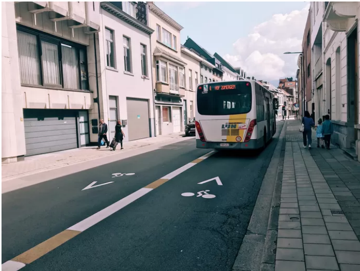
In de Esplanadestraat is er een busstrook en een fietsstraat. © RLA
