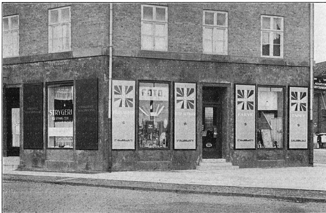
Ejendommen paa Hj. af Lyngbyvej og Æbeløgade. Arkitekt CARL BRUMMER.
