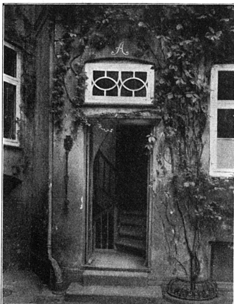
Opgang til Bagbygningen.
