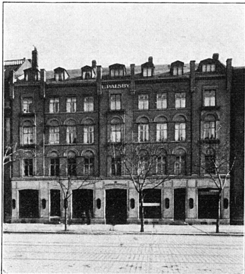
Ejendommen Holmens Kanal 7 for Ombygningen.
