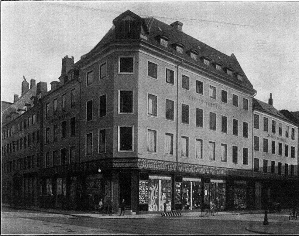
Daells Varehus efter Ombygningen.
