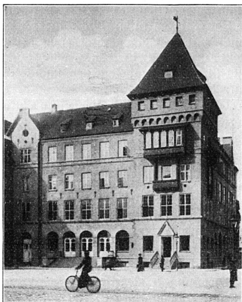
Studentersamfundets Ejendom, Hj. af Studiestræde og Nørregade, før Ombygningen.
