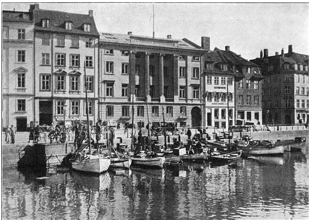
Fiskerbaadene ved Kanalen mellem Højbro og Holmens Bro.
