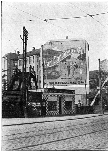
Gavl 1. Nørrebrogade (Jernbanecoverskæringen).
